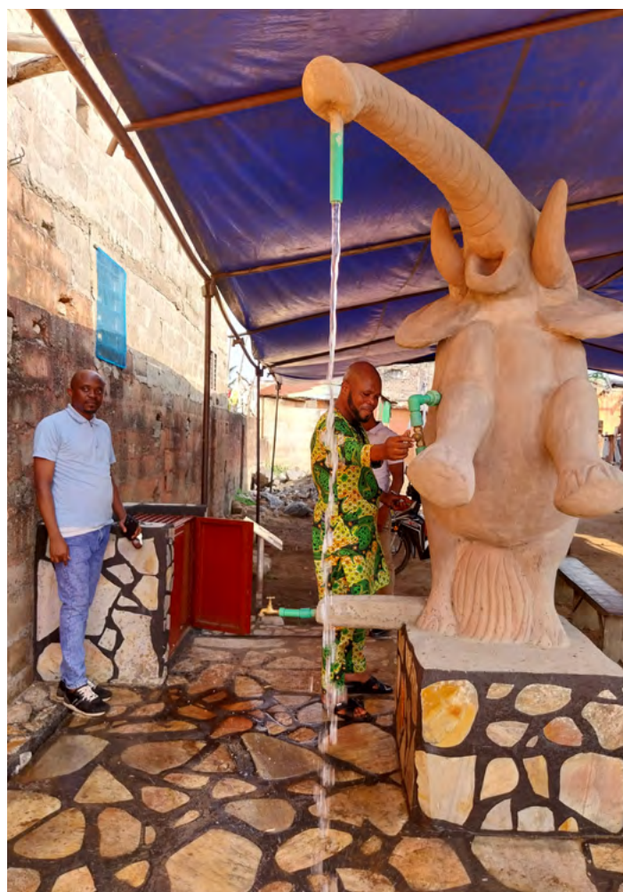
Installation de 19 fontaines à eau dans le 1 er arrondissement de Porto-Novo avec l'ONG Initiative Développement
