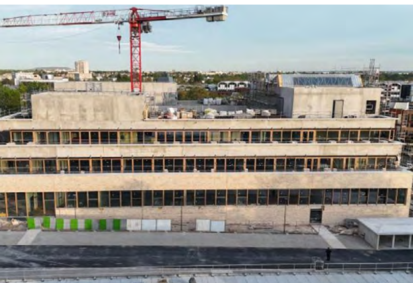
Construction de l'École Nationale Supérieure d'Arts de Paris Cergy
