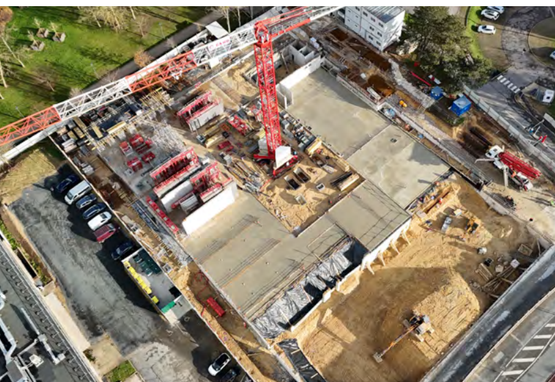
Construction du groupe scolaire Les Lucioles aux Marjoberts à Cergy
