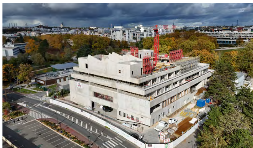
Vue drone des travaux de l'ENSAPC
