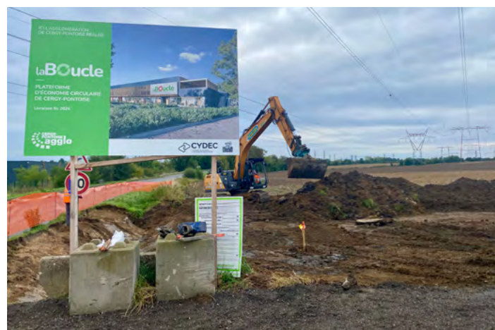
Travaux de la plateforme d'économie circulaire La Boucle
