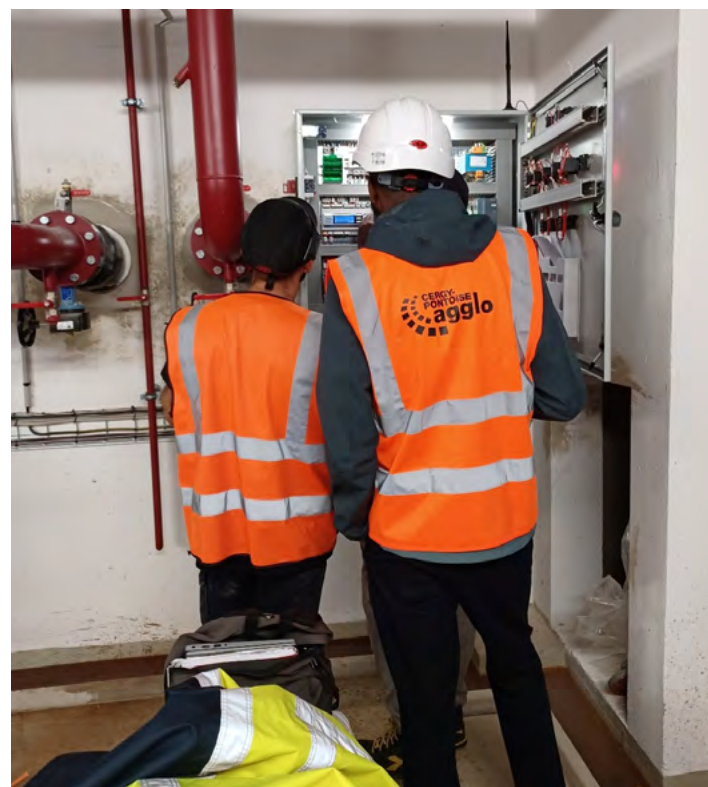
Opération de maintenance du chauffage urbain
