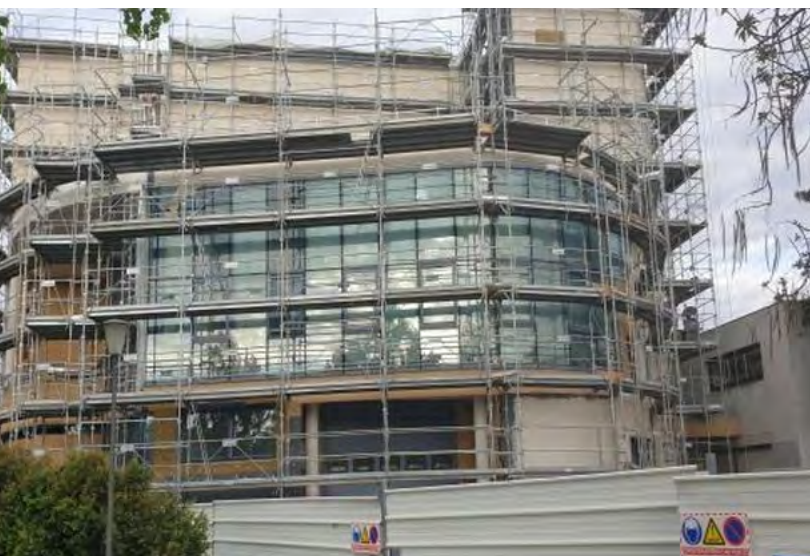
Construction du groupe scolaire Les Lucioles aux Marjoberts à Cergy
