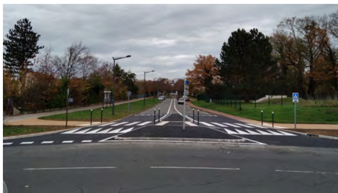
Sécurisation du giratoire du miroir à Courdimanche
