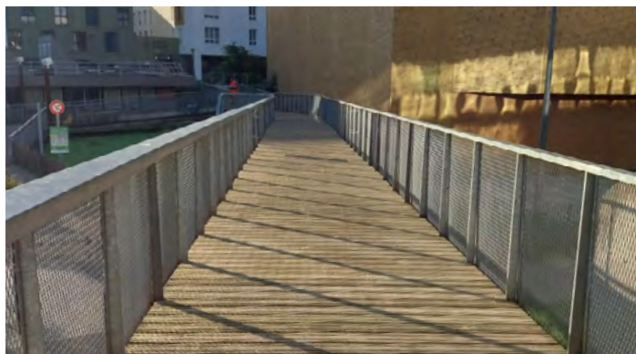
Réhabilitation de la passerelle du Verger
