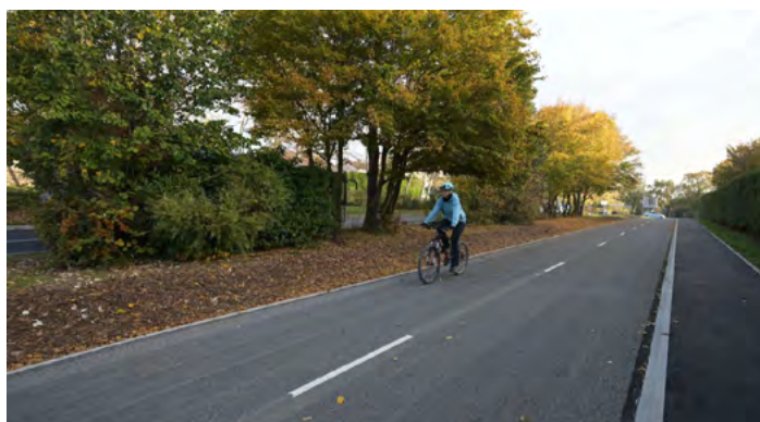
Aménagement de la branche V4 du réseau Vélo Ile de France à Cergy
