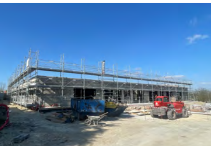
Chantier de la future crèche de Liesse 2
