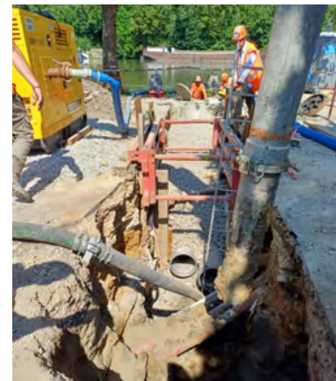
Pose d'un nouveau réseau EP rue Salvador Allende à Saint-Ouen l'Aumône
