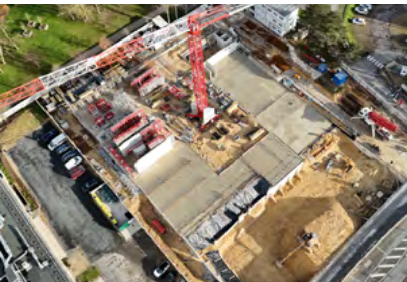
Chantier de la future École Nationale d'Art de Paris Cergy
