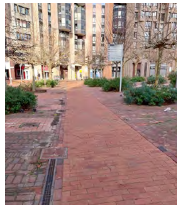
Rénovation des revêtements place Charles de Gaulle à Cergy
