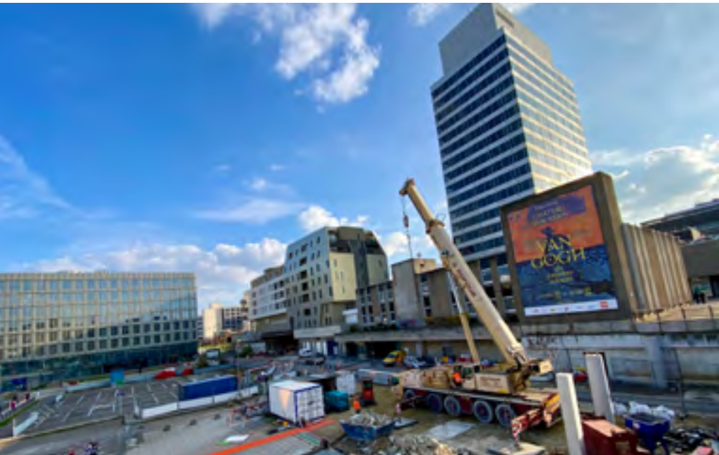
Travaux de création de l'escalier monumental du Grand Centre
