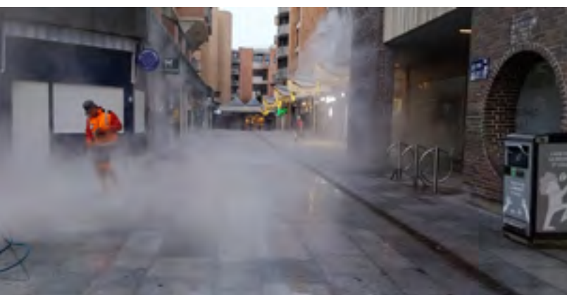
Décapage des revêtements sur la dalle du Grand Centre
