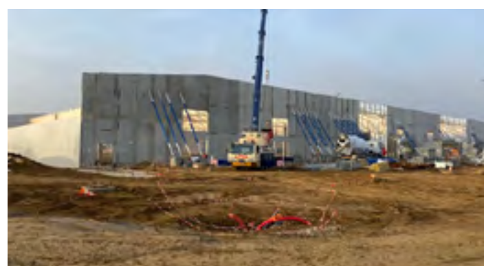
Chantier du futur bâtiment Vuitton Chaussée Osny
