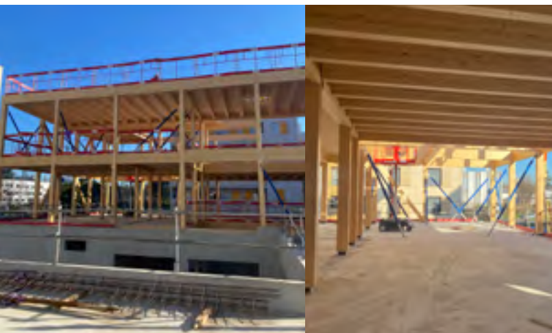
Chantier du futur groupe scolaire des Marjoberts
