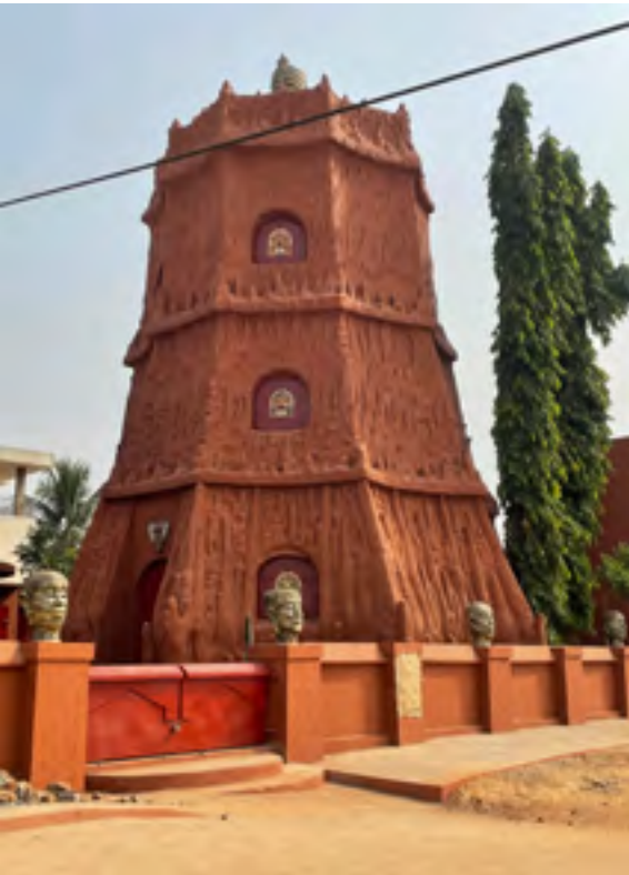
Réhabilitation de la place Abessan à Porto-Novo
