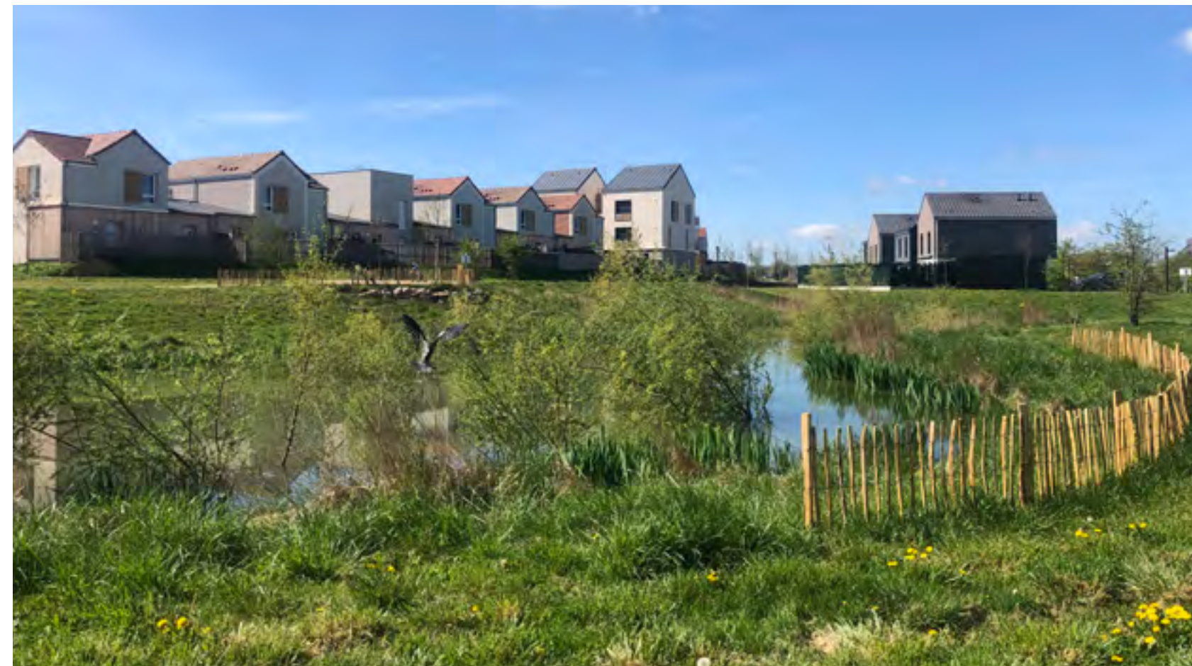
Écoquartier du Bois d'Aton à Courdimanche
