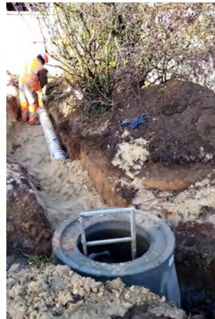
Travaux sur les réseaux d'eaux pluviales
