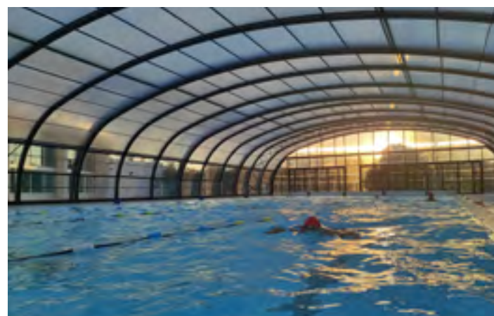
Le nouveau bassin de la piscine des Louvrais à Pontoise est équipé d'une toiture « rétractable »
