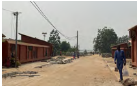
Aménagement des voies vers la lagune – Projet Porto-Novo ville verte
