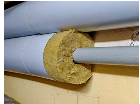
Réseau de chauffage en cours de calorifugeage
